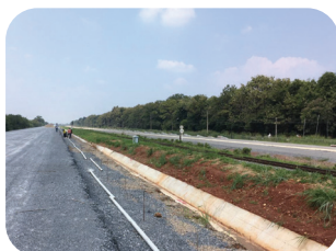
งานวางระบายน้ำ
