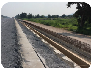
งานวางระบายน้ำ
